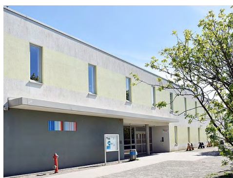
Blick auf den Erweiterungsbau mit "Warming Stripes"
